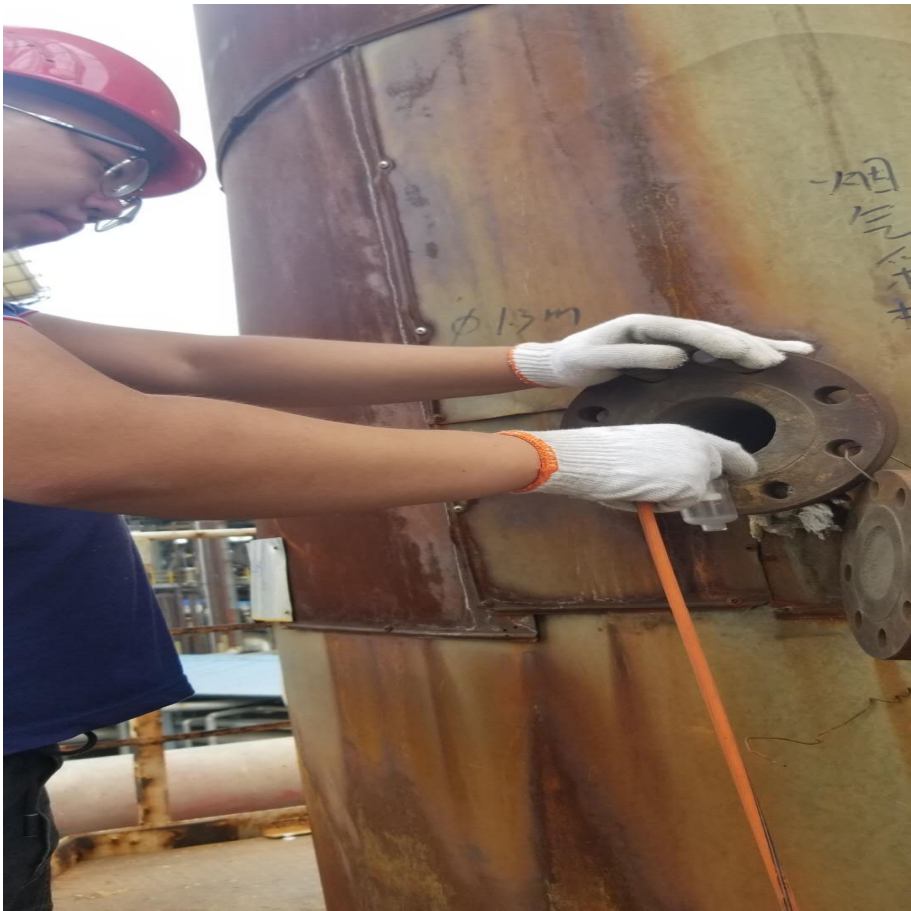
采样进口及采样平台照片
