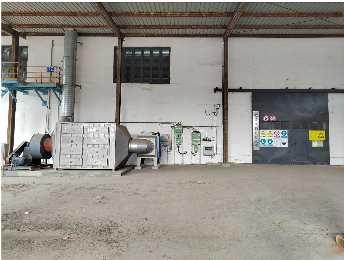
图 4.1-6 危险废物暂存间
