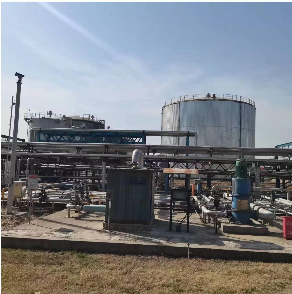
图 4.2-7 罐顶气进低压瓦斯系统
