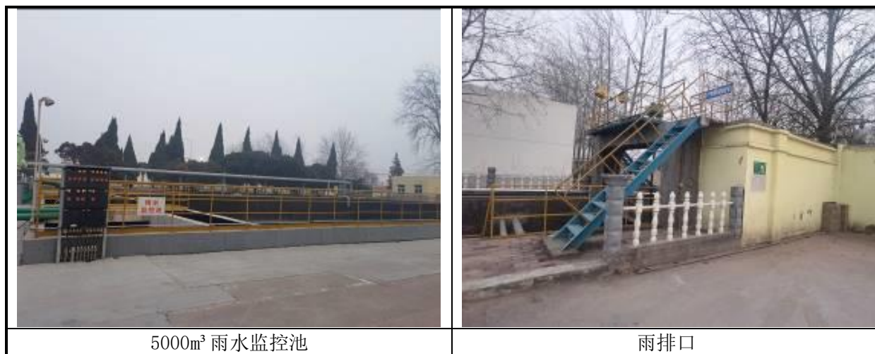
图 4.1-2 污水处理设施现场照片
