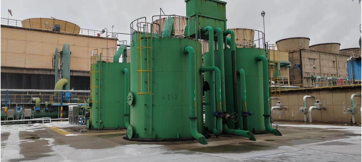
图 4.2-9 旁滤水治理项目
