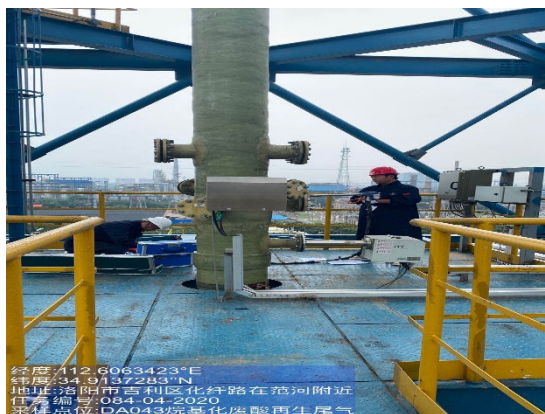
采样口及采样平台照片
