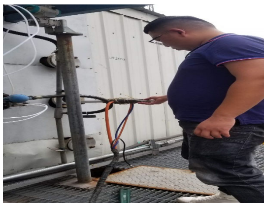
采样口及采样平台照片
