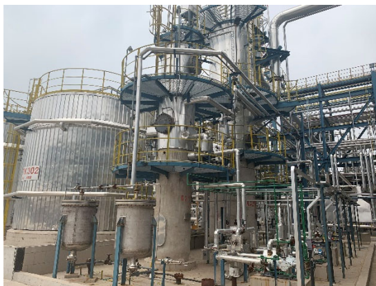
碱洗塔及含烃气体回收管道照片
