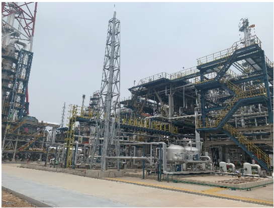
污水提升池密闭照片
